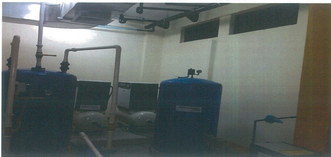
Mejora del Suministro de Aire Comprimido Medicinal del Hospital de Emergencias Pediátricas. Proyecto culminado y entregado a la entidad a inicios del año 2013.
